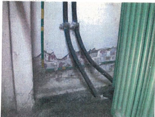
Opadávanie vnútorných omietok vo miestnosti s transformátormi
