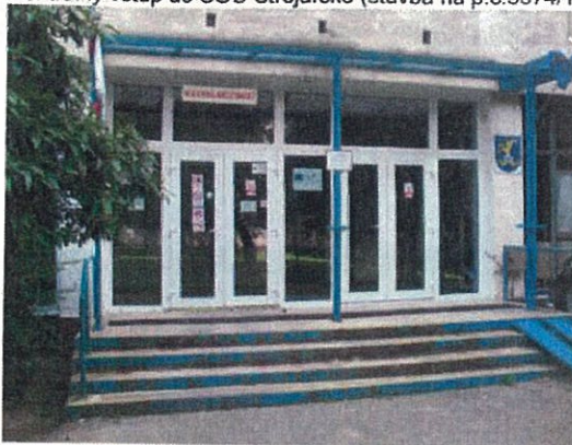
Centrálny vstup do SOU Strojárske (stavba na p.č.5574/1)
