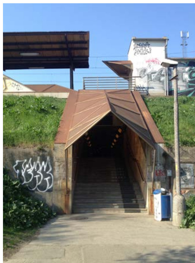
Prístupové schodište ŽST Bratislava – Vinohrady
