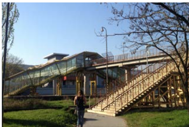
Nadchod ŽST Bratislava – Predmestie
