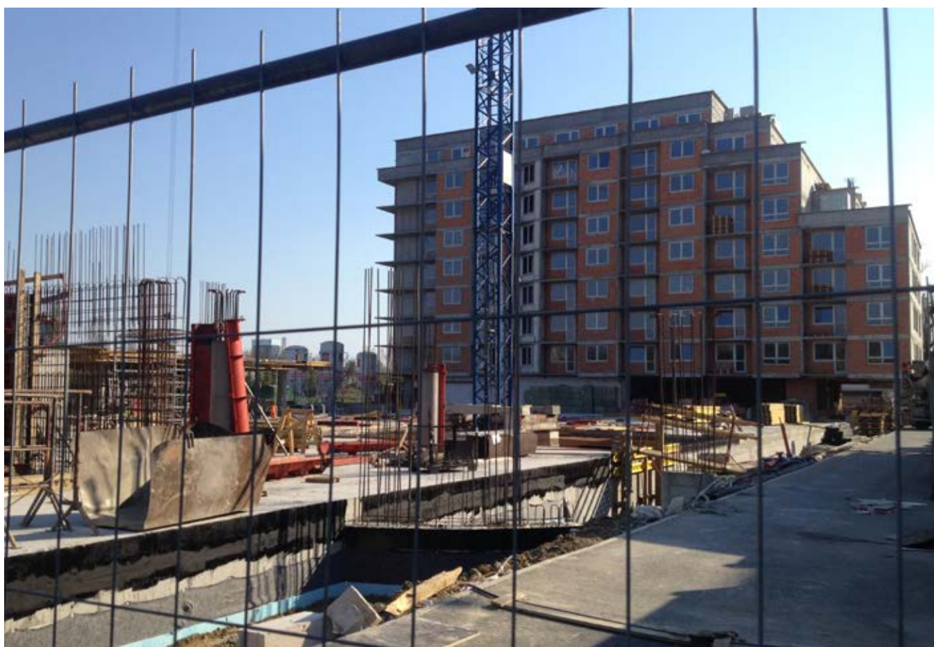
Bývalý atletický štadión ako miesto intenzívnej rezidenčnej výstavby, komplex Nobelova
