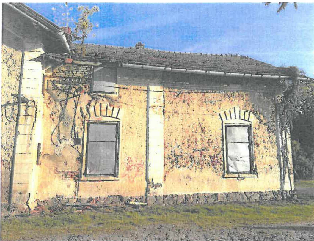
Foto 1: Pohľad na fasádu a strechu z južnej strany od cesty. Strecha je preliačená, perforovaná, rastie pod ňou vegetácia, časť krytiny chýba.
